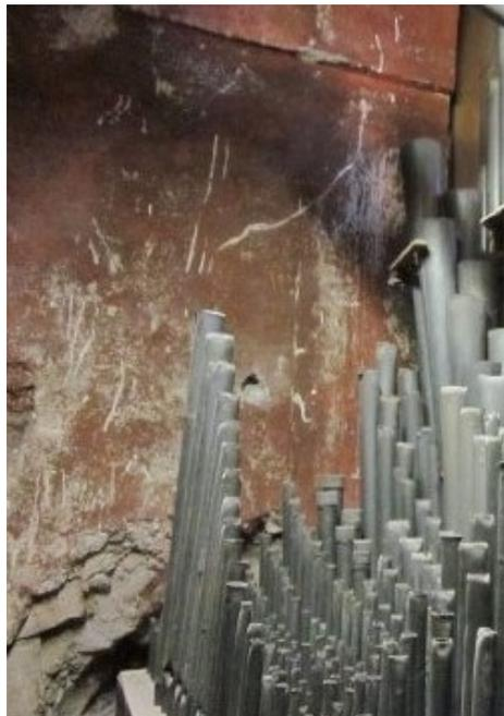
Fig. 22 – Particolare del materiale fonico prima del restauro e deterioramento dei muri perimetrali
